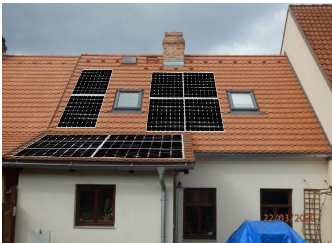
Obrázek 14: Návrh rozložení panelů na jižní střeše
