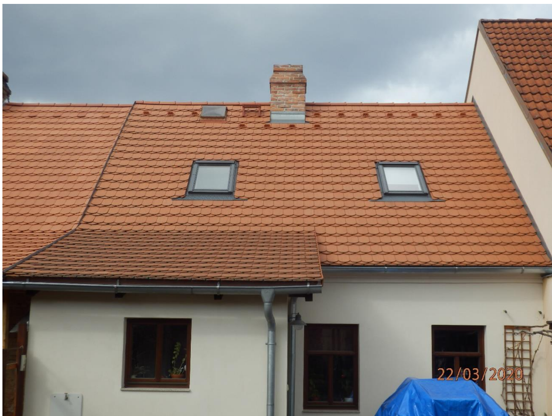
Obrázek 10: Rodinný dům a jeho jižní střecha
